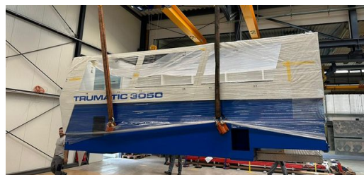
<p>Tung last: Den sju ton tunga baren anländer till företaget Matussek Metalltechniks monteringshall.</p>
