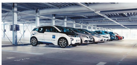
Posto de combustível elétrico: em Ditzingen, 86 estações de carregamento estão disponíveis no próprio estacionamento da empresa para uso dos funcionários. Além disso, a TRUMPF está eletrificando sua frota.
