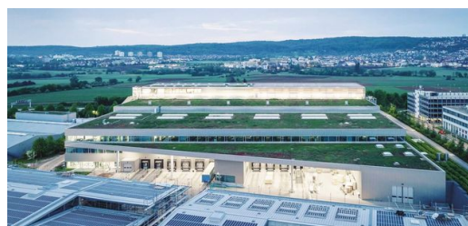
Energia elettrica dal tetto dello stabilimento: TRUMPF sta espandendo costantemente la produzione di energia da fonti proprie, ad esempio attraverso grandi impianti fotovoltaici.
