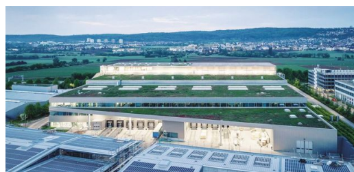
Energia elettrica dal tetto dello stabilimento: TRUMPF sta espandendo costantemente la produzione di energia da fonti proprie, ad esempio attraverso grandi impianti fotovoltaici.
