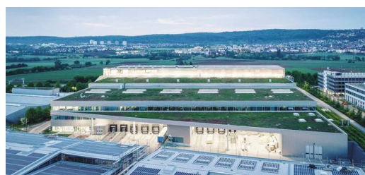
De l'électricité sur le toit de l'usine : TRUMPF développe systématiquement la production d'énergie à partir de ses propres sources, par exemple grâce à de grandes installations photovoltaïques.
