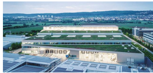
Electricidad desde el tejado de la fábrica: TRUMPF está ampliando constantemente la generación de energía a partir de fuentes propias, por ejemplo mediante grandes sistemas fotovoltaicos.
