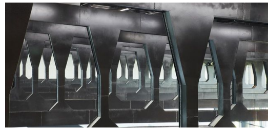
Der Skywalk ist Teil der frei tragenden Deckenstruktur aus Stahl, die von einem TRUMPF Kunden in Atlanta gefertigt wurde. Bild: Steve Hall © Hall+Merrick
