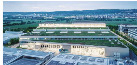
Electricidad desde el tejado de la fábrica: TRUMPF está ampliando constantemente la generación de energía a partir de fuentes propias, por ejemplo mediante grandes sistemas fotovoltaicos.
