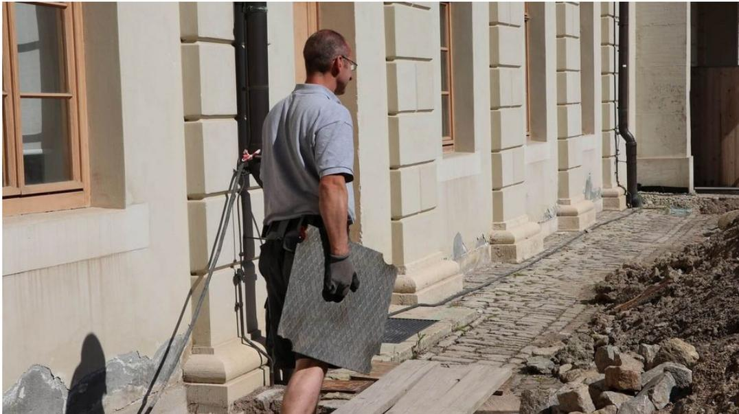
Rund 320 Quadratmeter Stahlbleche mussten entfernt werden. In handlicher Größe ließen sich die ausgenibbelten Stahlbleche einfach entsorgen.
