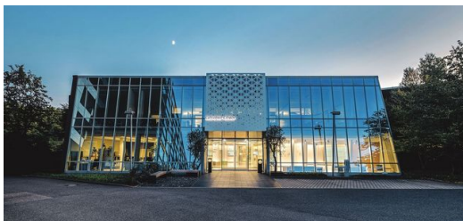
Kundenzentrum: Eine schöne Industriearchitektur in Kombination mit einer hohen Produktqualität soll die TRUMPF Kunden überzeugen.
