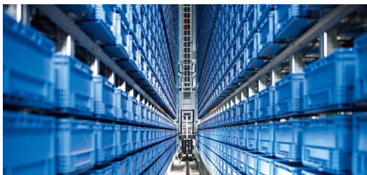
Das automatische Kleinteilelager (AKL) mit 23.000 Behälterstellplätzen. Bild: Claus Morgenstern
