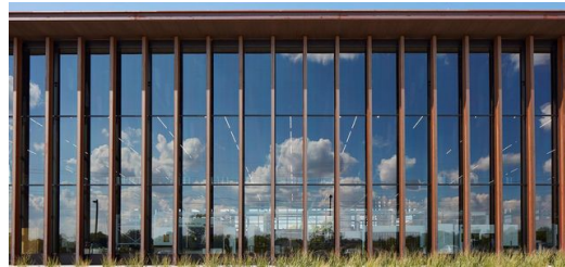
Im Fokus der Smart Factory stehen Beratung und Training der Kunden bei der Einführung von digital vernetzten Fertigungslösungen. Bild: Steve Hall © Hall+Merrick
