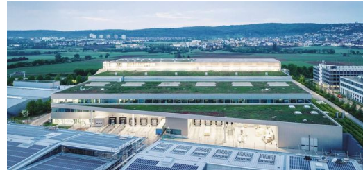
Strom vom Fabrikdach: TRUMPF baut Energiegewinnung aus eigenen Quellen konsequent aus, etwa durch große Fotovoltaikanlagen.
