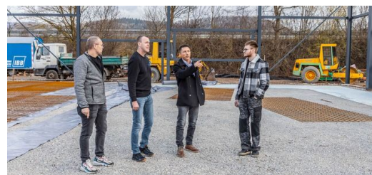
Im September 2023 ist der Umzug von DELO ins benachbarte Hechingen geplant. Die Bauarbeiten sind in vollem Gange. Mit einer bebauten Fläche
