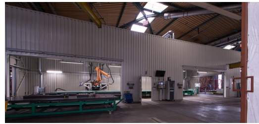
In ihren Laserkabinen fertigt die Photon AG Waggonseitenwände mit bis zu 25 Meter Länge. Bild: Angelika Grossmann
