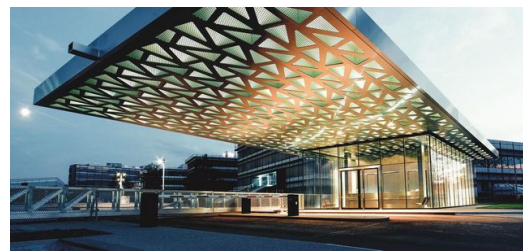
Haupteingang und Empfang: Der Blick zur Decke genügt – Besucher erkennen gleich, dass sich mit TRUMPF Maschinen Bleche lasern lassen.
