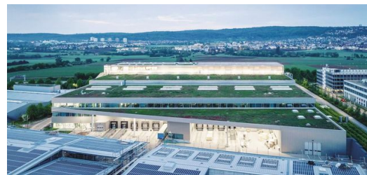
Strom vom Fabrikdach: TRUMPF baut Energiegewinnung aus eigenen Quellen konsequent aus, etwa durch große Fotovoltaikanlagen.
